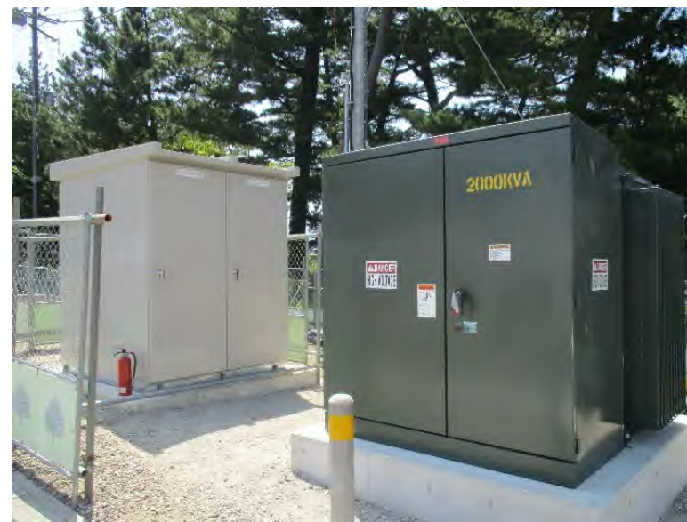
商用電力導入のための機器の設置
