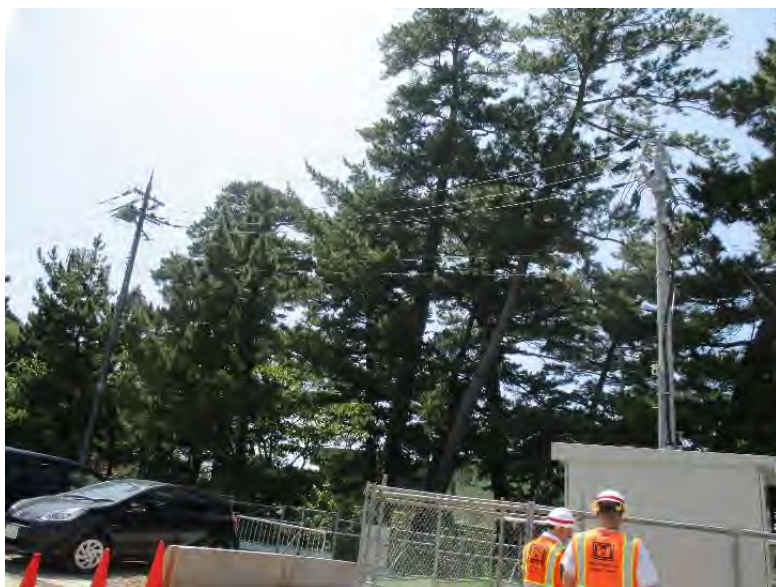
関西電力電柱(左)から受電する通信所内の電柱(右)
