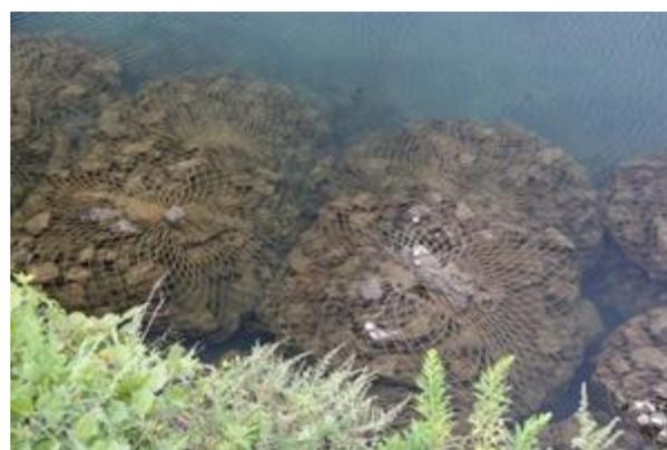
図 6-8 袋型根固め型待避施設
