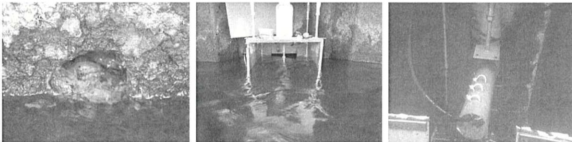
図 1-5-6 湧水観測装置の様子（左：矢板 I 湧水孔、中央：設置した観測装置、右：観測管）
