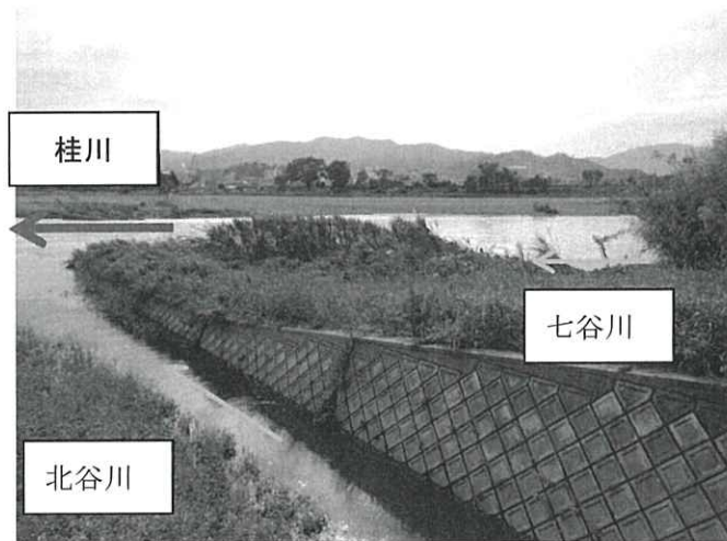
写真 1-4-1 七谷川・北谷川合流状況
