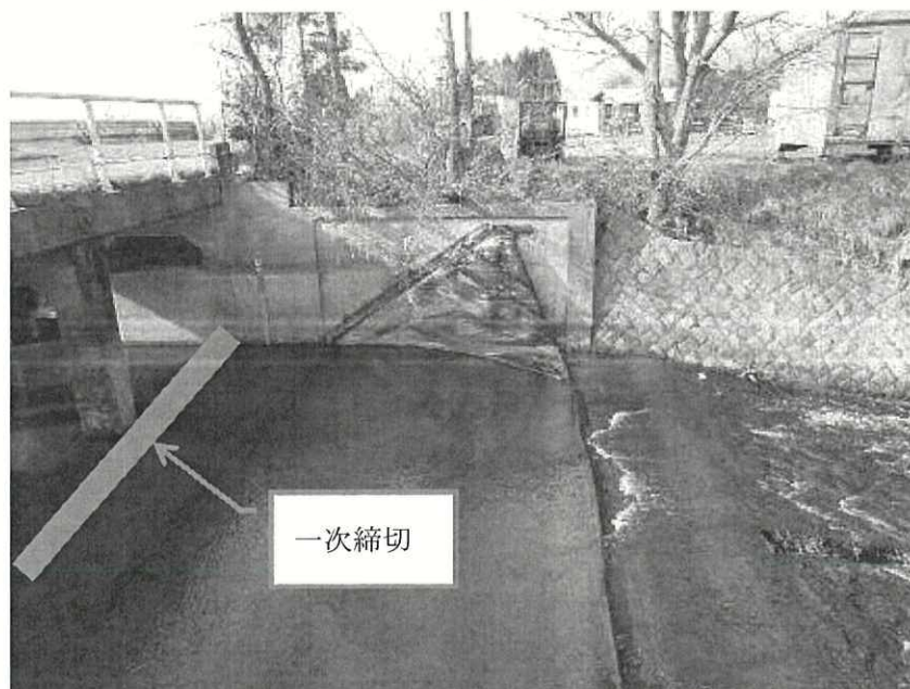
【写 3-1-2 一次締切設置箇所】
