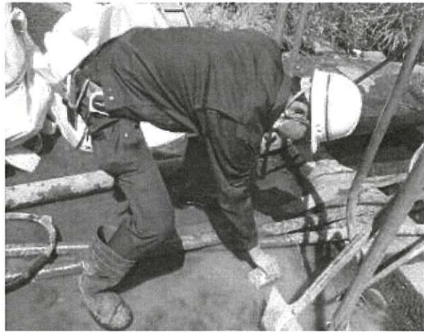
【写 3-1-6 コア抜き時採水状況】
