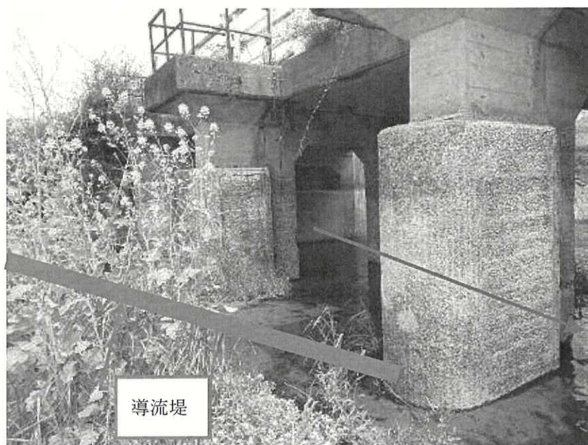
【写 3-1-1 導流堤設置橋脚部】
