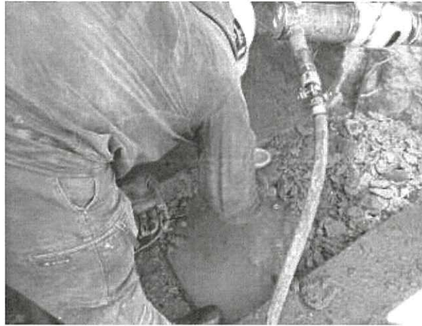
【写 3-1-5 ハツリ時採水状況】
