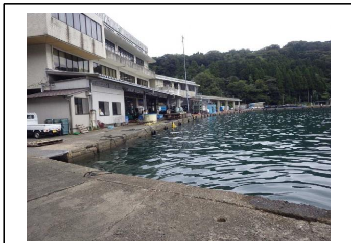
大浦第1岸壁 全景
