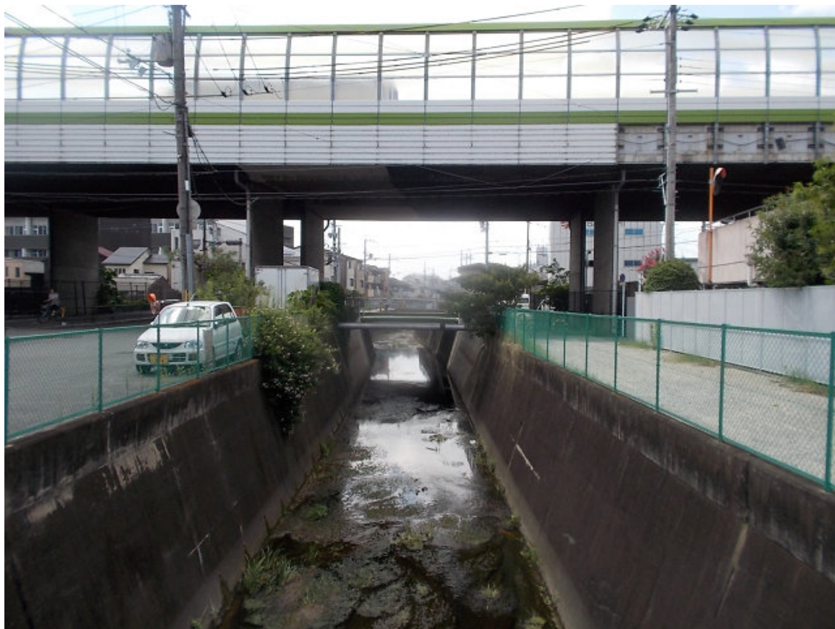
東高瀬川 新竹田出橋
