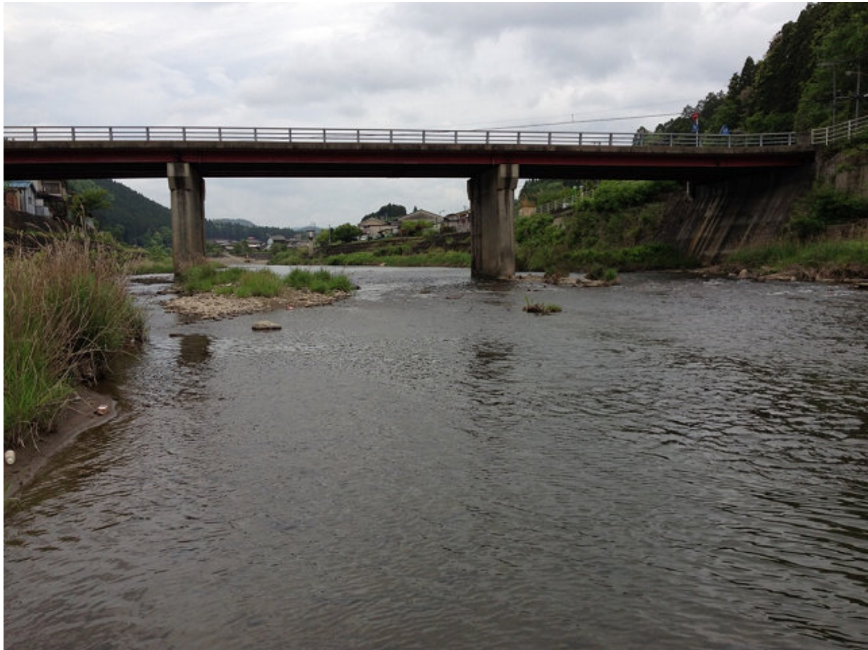
桂川 八千代橋
