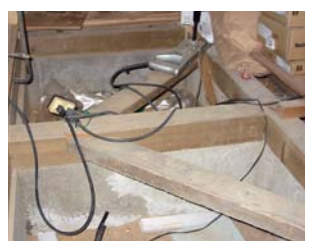
鉄筋コンクリートの基礎にやり替え、土台をしっかりと固定。基礎は耐震化の重要なポイントです(塩貝邸)
