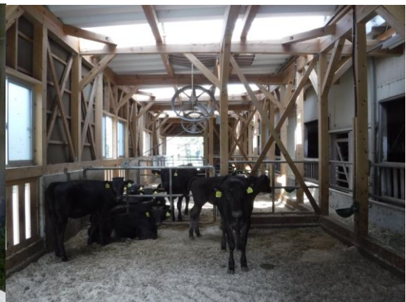
大型扇風機を設置
