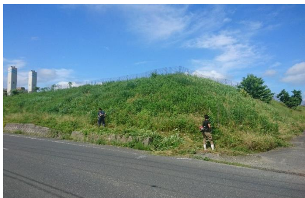
圃場法面 刈払作業
