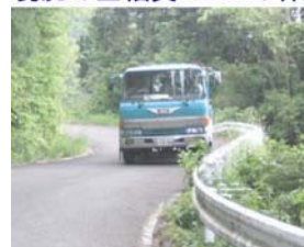
現況の全幅員4.0mの林道
