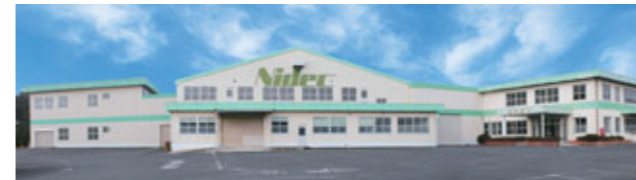
日本電産旧峰山工場を活用して整備が進む拠点
