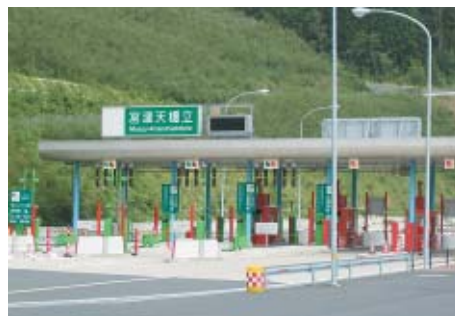
▲京都縦貫自動車道宮津天橋立 | C
