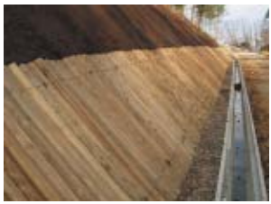
▲丸太伏工の施工事例
