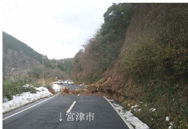
<被災後の状況>
