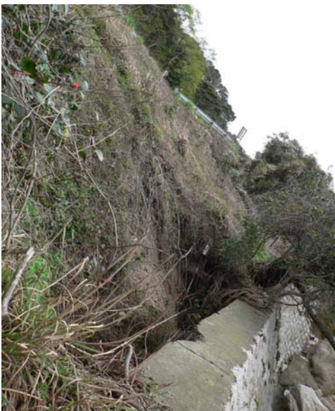
老朽石積擁壁の背面の現状
