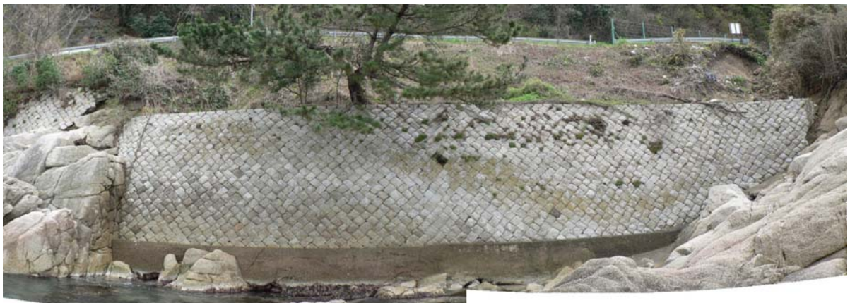
老朽石積擁壁の背面の現状
