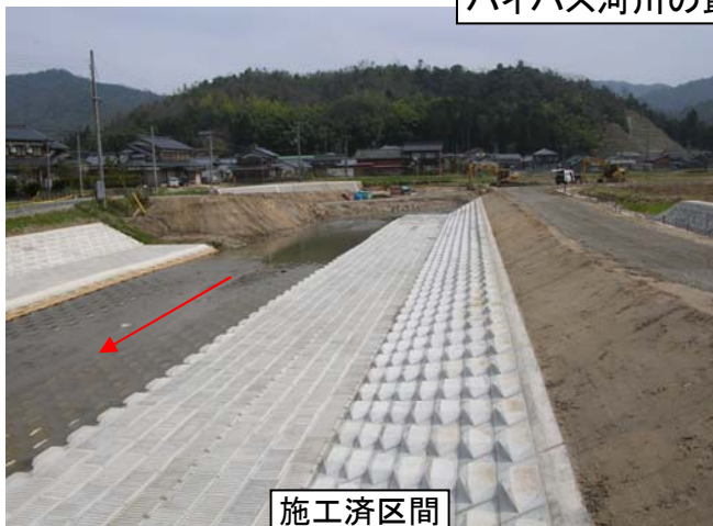
バイパス河川の最上流部を施工します
