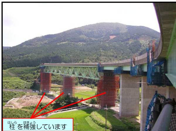
柱の補強工事
