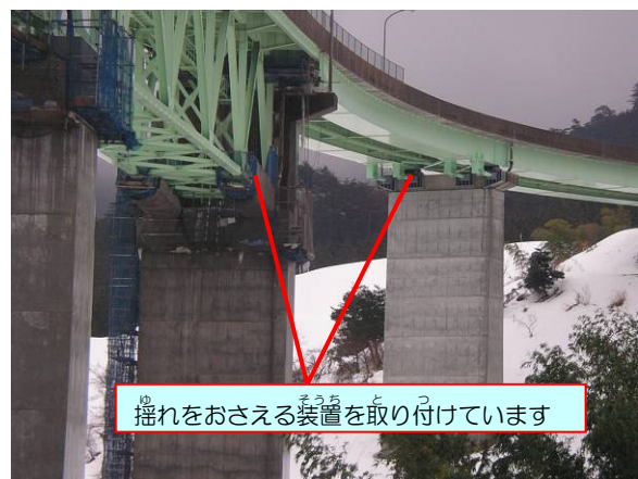
ダンパー（揺れをおさえる装置）の設置
