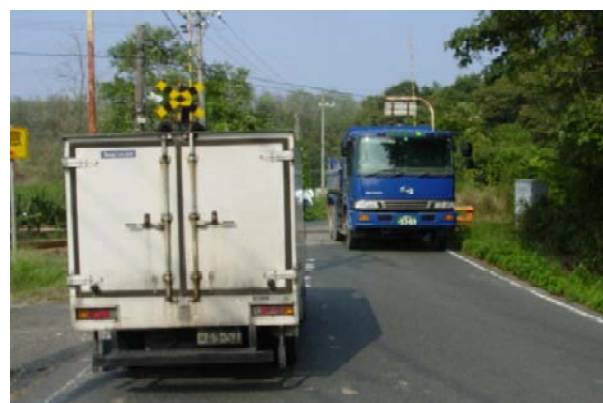
現況（久美浜町平田地内）
