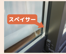
▲複層ガラスやトリプルガラスの見分け方：内部に銀色のスペイサー（金属の部品）が挟まれています。
