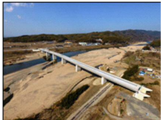
施工の状況（木津川渡河橋梁部）
