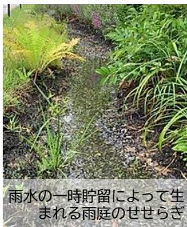
屋根の雨水を開放樋から雨庭へ流す雨道
