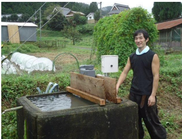
給水ラインの中継槽に設置
