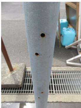
写真3 消毒ゲートの噴射孔
