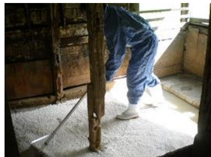
写真1 生石灰の敷き均し作業
