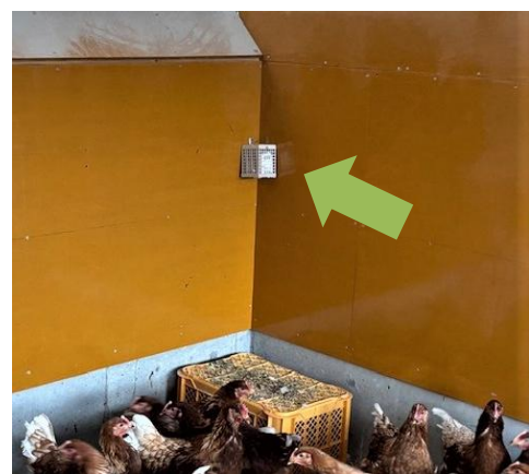
鶏舎内に設置した温度センサー (矢印)
