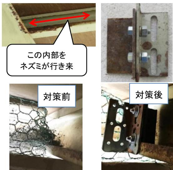
写真 21 リップ溝形鋼切断面の対策
