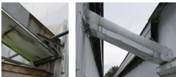
写真 13 バーコンベア開口部対策例 1
