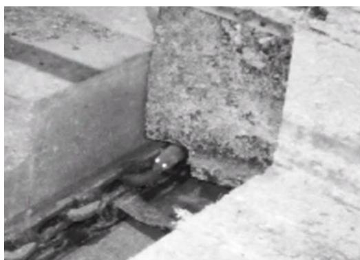
写真7 バーコンベアと蓋の隙間から出入するネズミ
