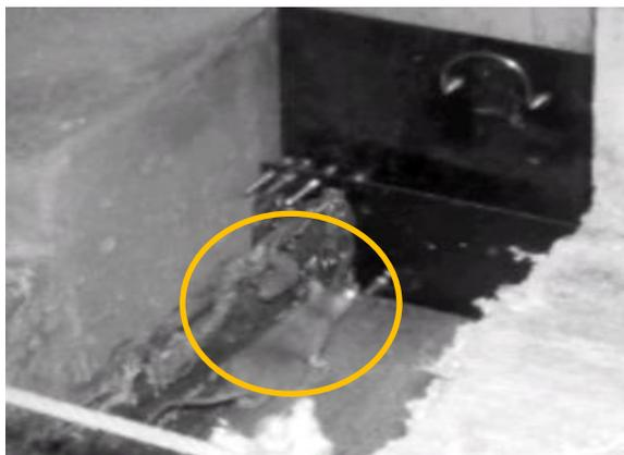
写真 18 鉄板とチェーンを組み合わせた蓋により侵入できないネズミ
