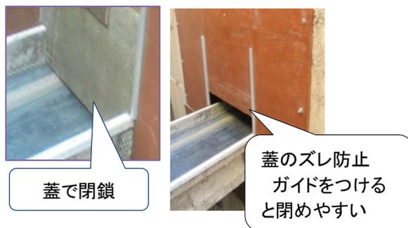
写真 17 集糞コンベア開口部対策例 2
