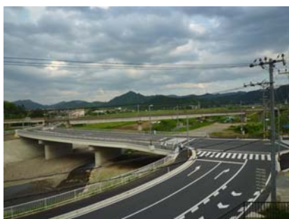
国道175号宮川橋
