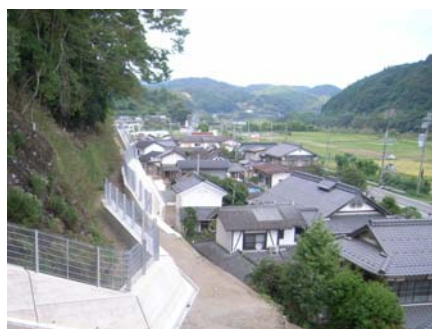
下天津急傾斜地
