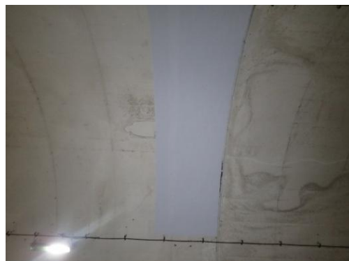
（補修工事完了後）
