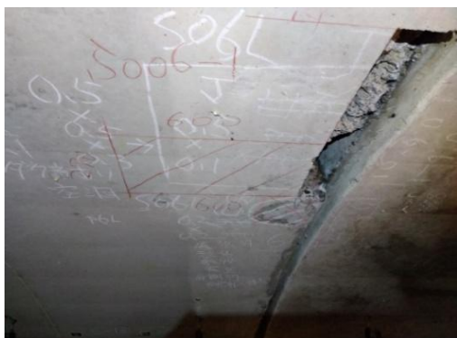
（補修工事着手前）
