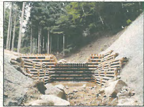
①木製治山ダム
