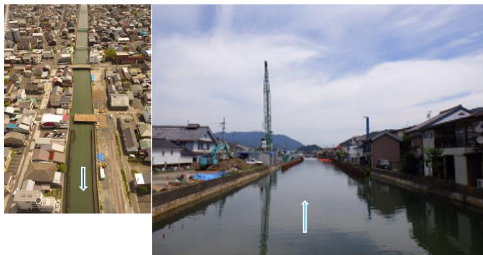
高野川河川改修（舞鶴市竹屋～引土）
