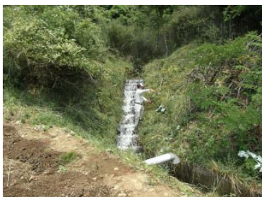
▲階段落差工水路(草刈)
