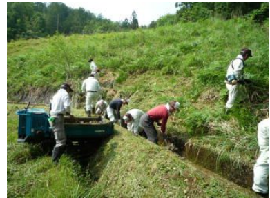
▲ため池下の水路土砂撤去
