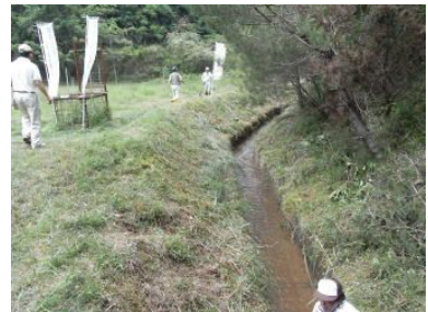
▲外周部の水路(作業後)
