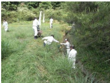
▲外周部水路清掃(作業中)
