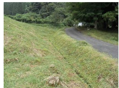
▲草刈作業後の水路
