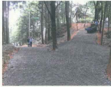
200mもの作業道が仕上がりました。
