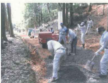
採石を敷いていきます。
