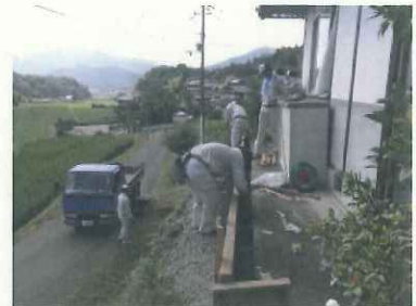
浮き上がった犬走りの補修
