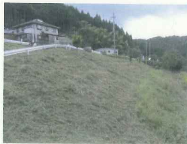
作業後の法面の様子
