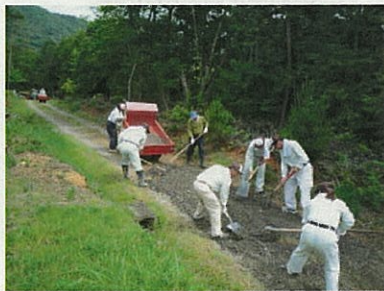
碎石敷き均し100m
