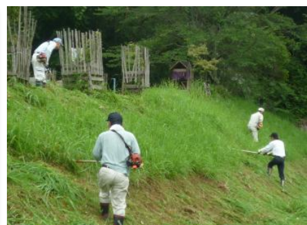
道路脇法面の草刈り(法用)
