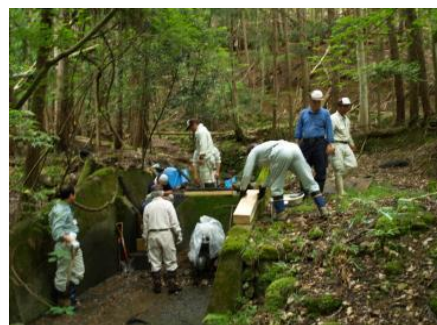
農業用水取水口の堰板更新
