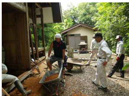
御輿収蔵庫の床整備
