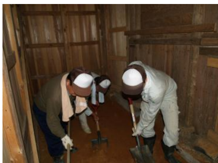
御輿収蔵庫の床整備
