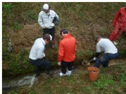
農業排水路の泥上げ・清掃
