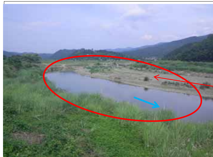
浚渫工、 河床整正
