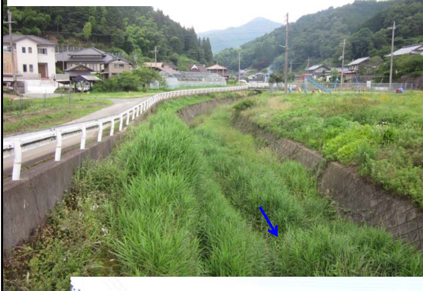
国道より160m上流地点
