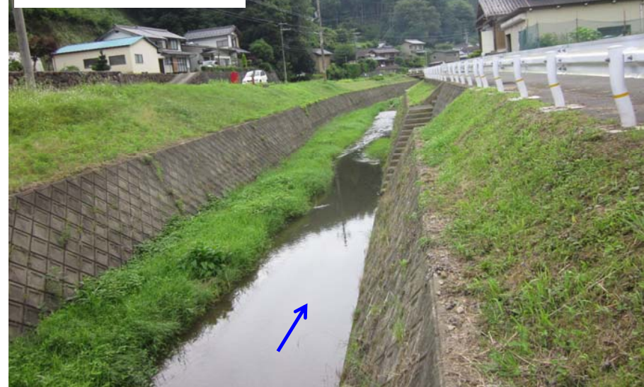
国道より600m上流地点
