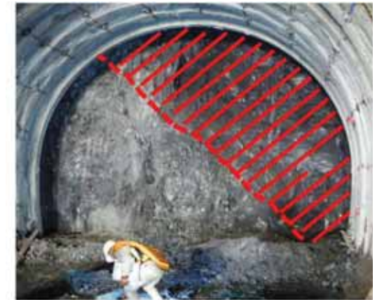
赤斜線部は脆弱層(破砕帯)を示す
