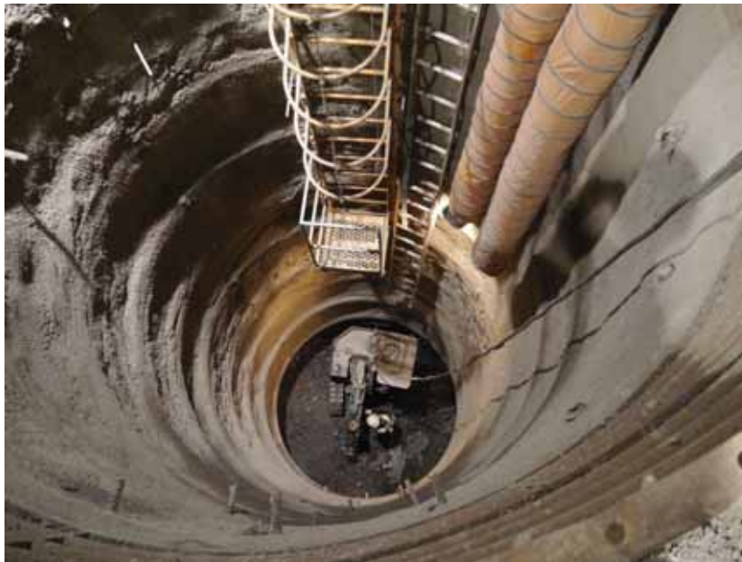
側壁導坑内(右)掘削状況(H28.8.23)
