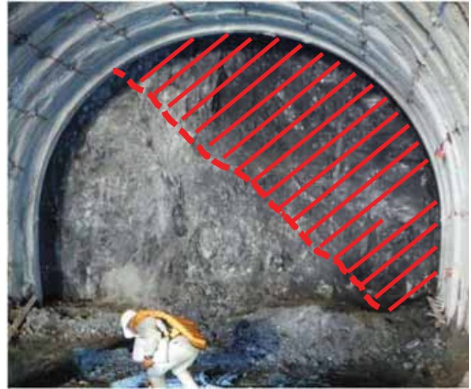
赤斜線部は脆弱層(破砕帯)を示す
