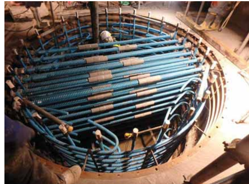
側壁導坑内(左)鉄筋組立状況(H28.8.26)
