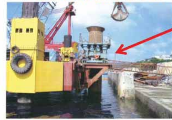
〔 施工例(水上施工) 〕
