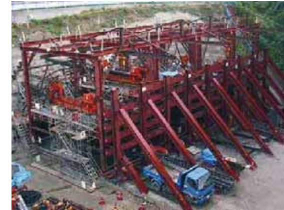
パイプルーフ推進架台全景(事例)
