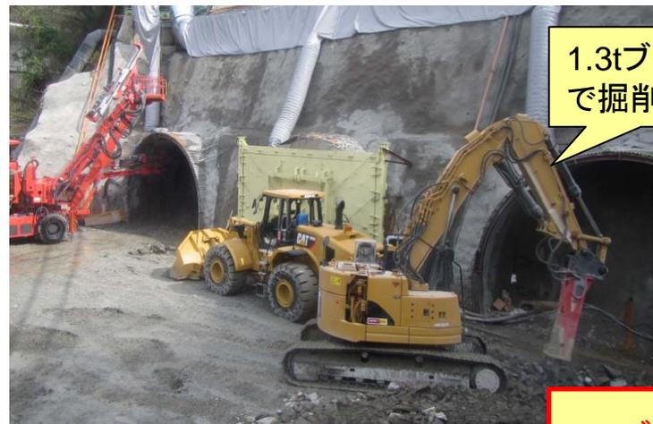
▲1.3t級ブレイカによる先進導坑の施工状況
