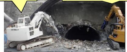
▲【上半部】4.0t級ブレイカーによる掘削状況
