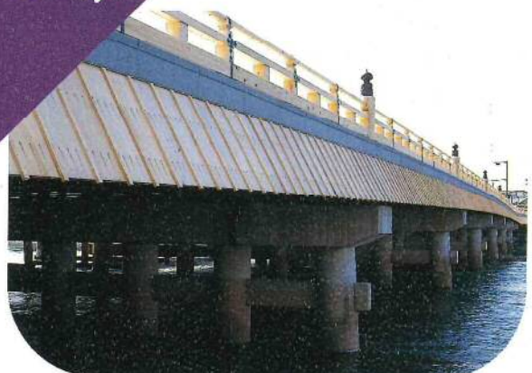
木橋の姿をイメージした橋脚・桁かくし
