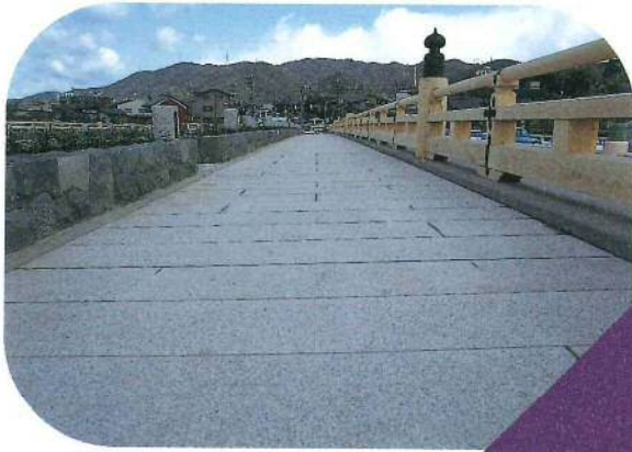
大版の御影石を使用した歩道
