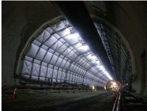
写真 5.3.3 給水養生（アクアカーテン養生）の事例 19)
