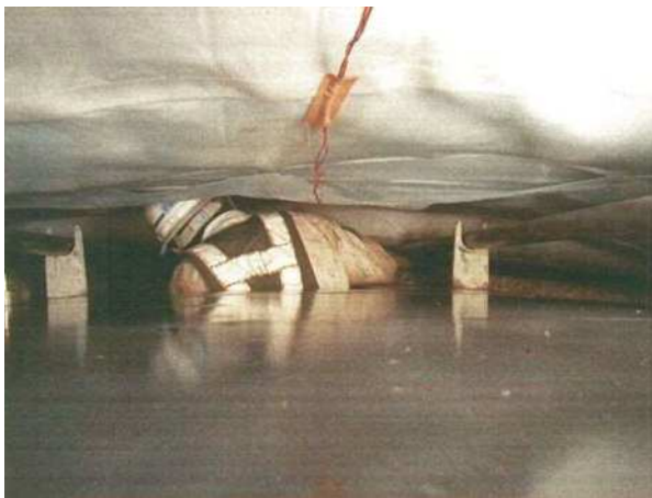
天端部の打設状況
