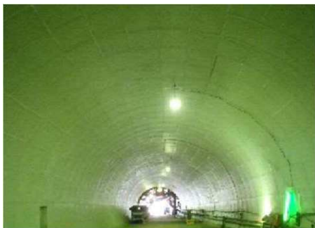
写真 5.3.5 シート養生の事例 21)
