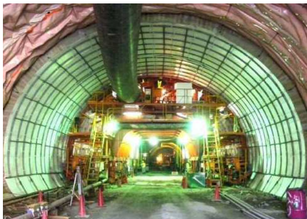
写真 5.3.4 パネル養生の事例 20)
