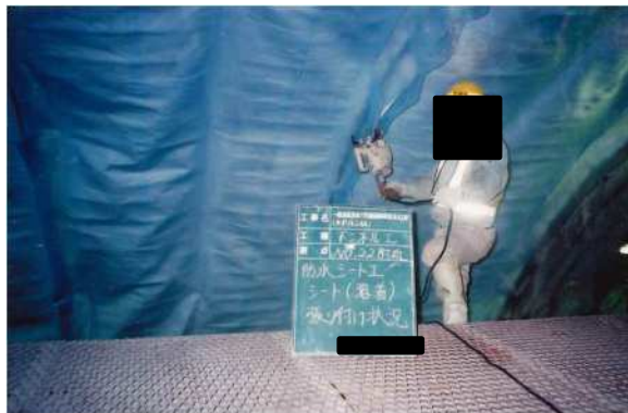
写真 1.3.6 防水シート接合
