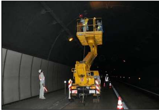
トンネル点検車による点検
