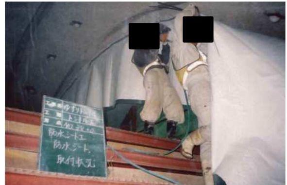
写真 1.3.5 防水シート取付け
