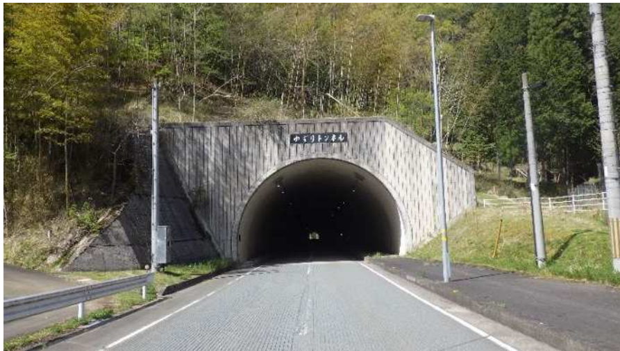
写真 2.1.2 府道談夜久野線ゆずりトンネル（L=455m）
