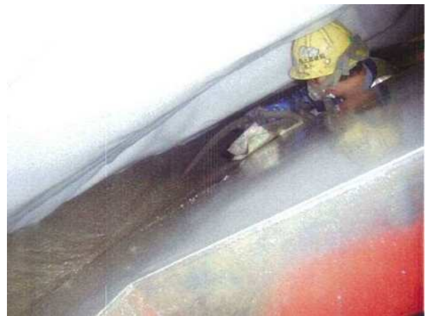
アーチ部の打設状況写真
