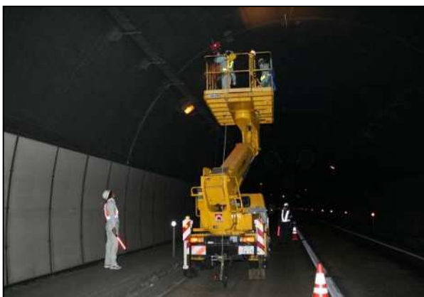
写真 4.2.1 電磁波探査測定状況の例
